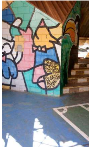
houve roubo do quadro de energia e fiação
