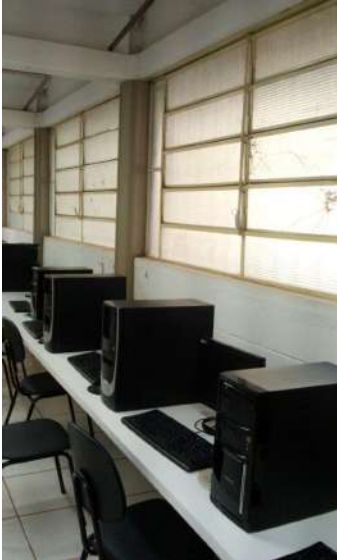
vidros da sala de informática quebrados
