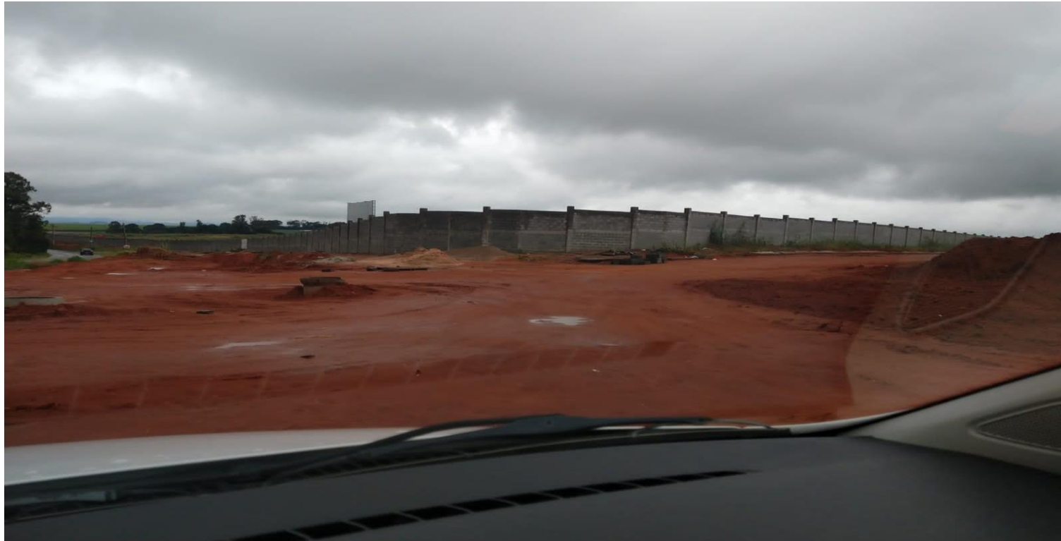
Construção do Condomínio Avenida Garden – Empreendimento Reserva da Cachoeira
