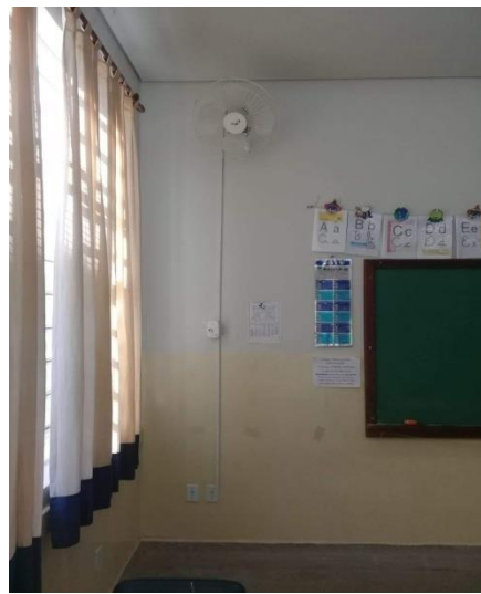
Depois: Funcionando instalação realizada
