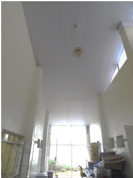
Reparo realizado com verba do PAFE
