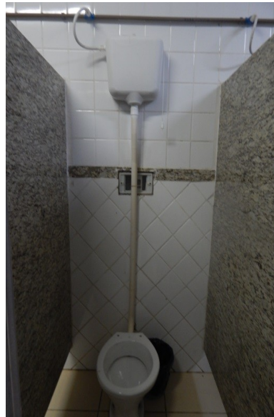
As válvulas foram substituídas por caixa de descarga.
