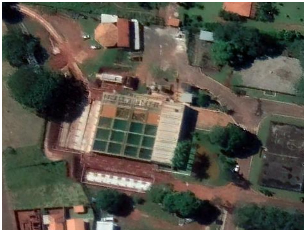
FIGURA 5. ETA – Estação de Tratamento de Água.
